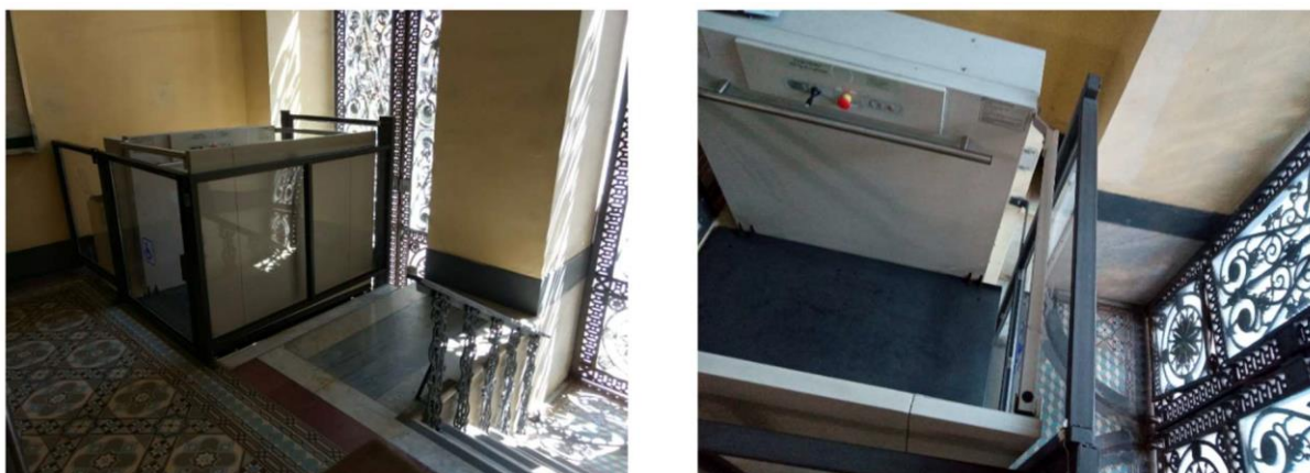
Figura 2: Plataforma elevatória para acessar a entrada principal da Uned.
