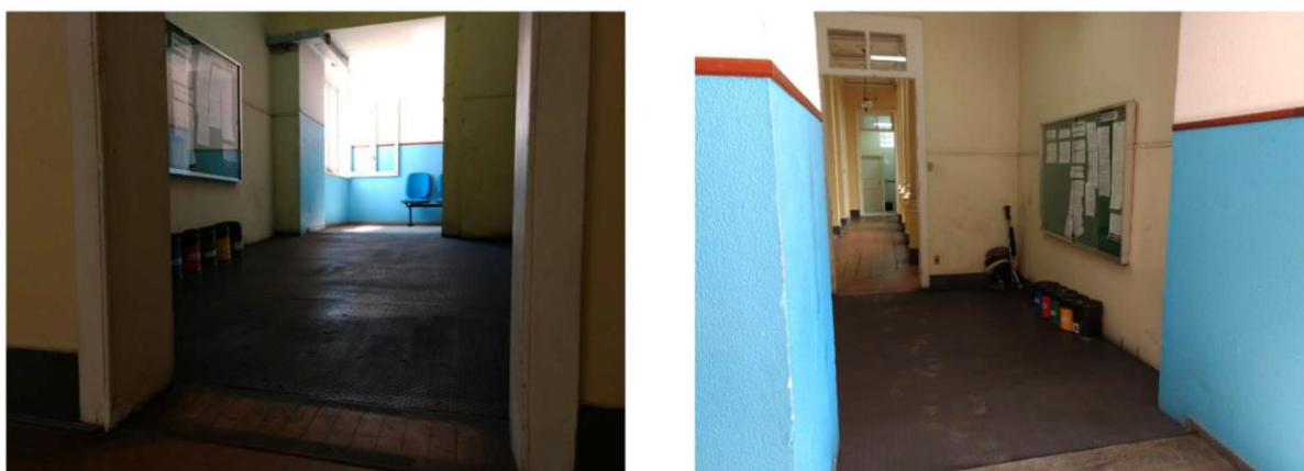
Figura 1: Instalação de rampas entre os ambientes desnivelados
