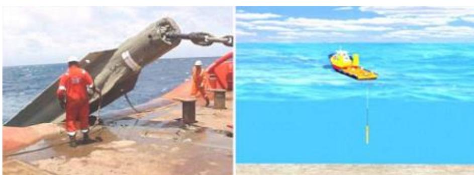
**Figura 27:** Lançamento de estaca torpedo [9]
