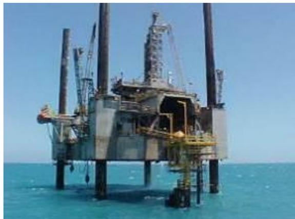
**Figura 6:** Plataforma tipo auto – elevatória com estrutura tubular [9]
