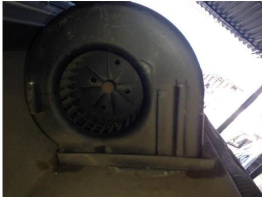
Foto – Motor (eletroventilador) do evaporador.
