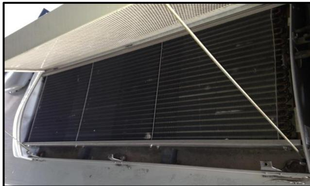
**Figura 9:** Foto do condensador com a tampa de proteção aberta.
