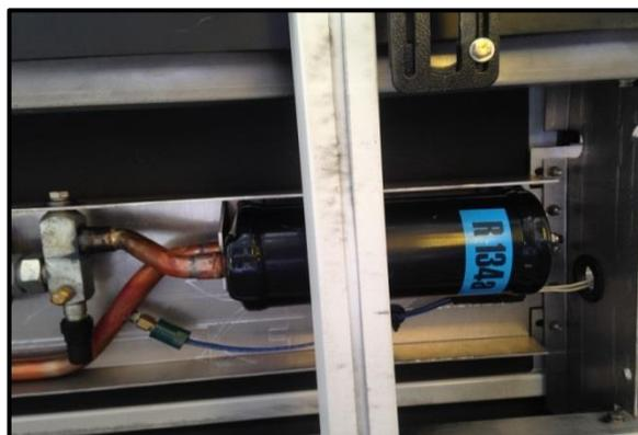
**Figura 14:** Foto do cilindro comercial de gás R134A
