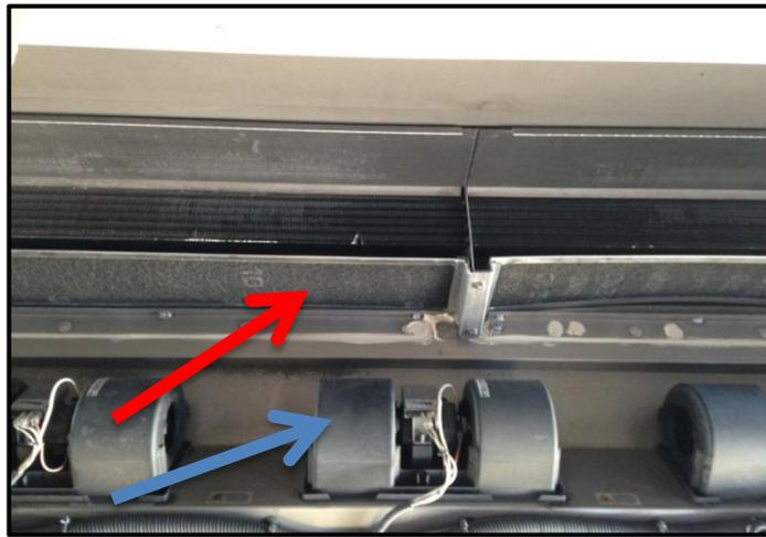
**Figura 10:** Foto do Evaporador (está indicado pela seta vermelha e os motores estão indicados pela seta azul).
