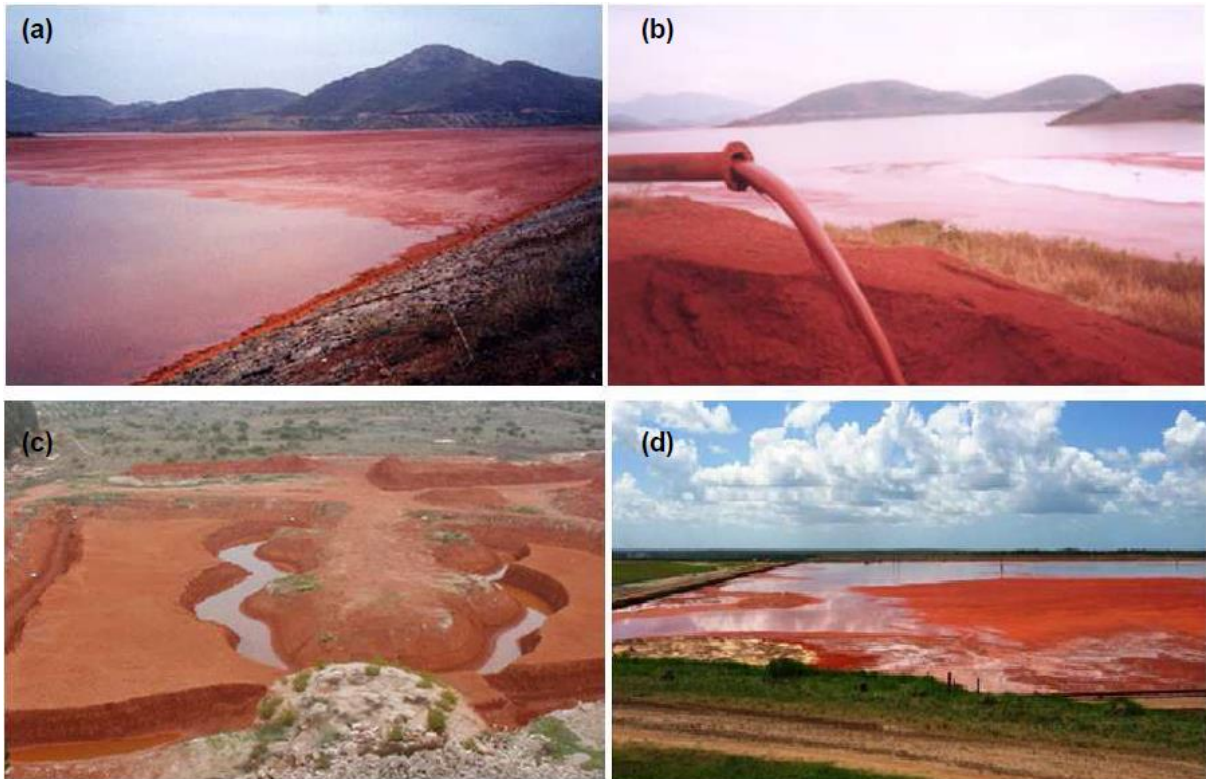
Figura 2.2.1– (a) e (b) Lagoa de deposição na Índia, (c) Lagoa de deposição na França e (d) Lagoa de deposição no Maranhão – BR [04].
